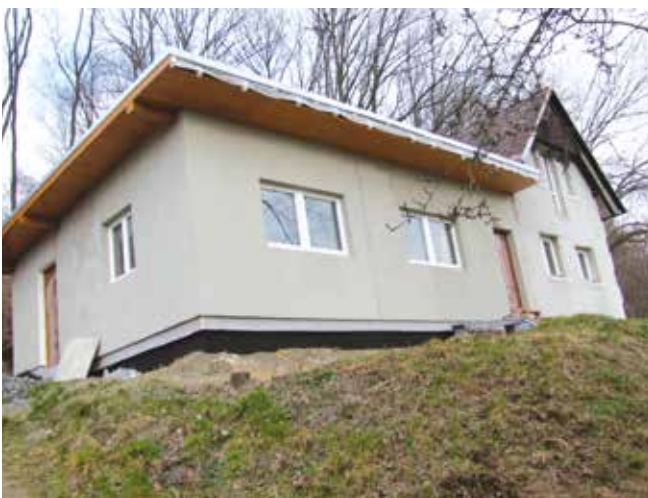
Přístavba k domu - Proskovice
